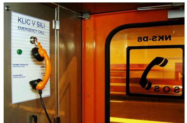
In-tunnel SOS niche, Šentvid, SLO
