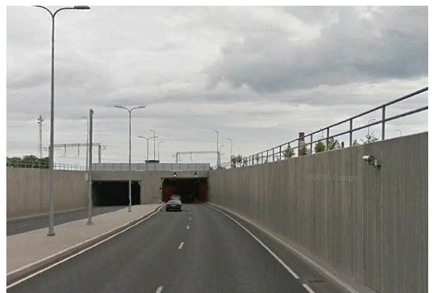
Järvevana tunnel, Talinn, Estonia
