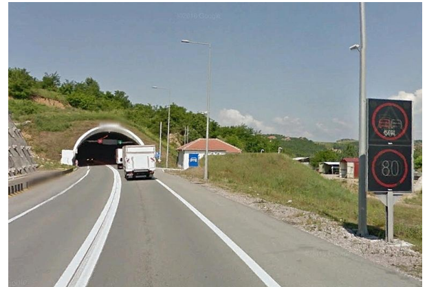
Stražeвица tunnel, SRB
